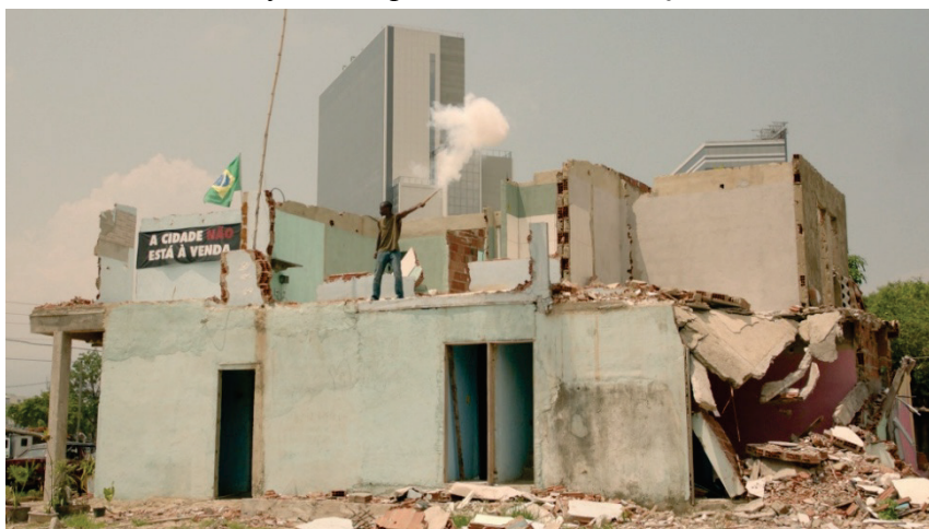
Figura 1 Edifício em processo de demolição.
