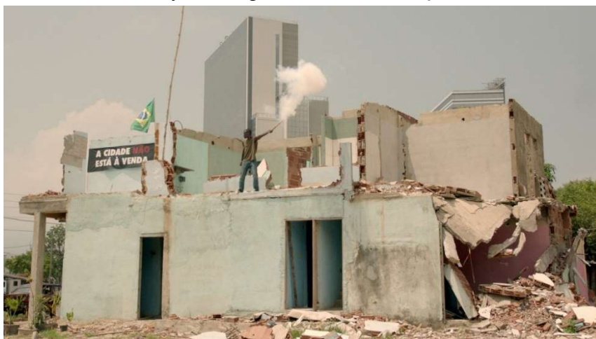
Figura 1 Edifício em processo de demolição.
